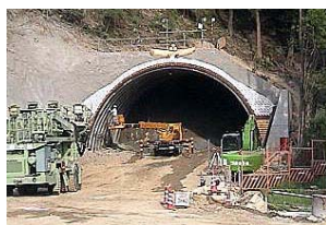
山間部での工事現場
